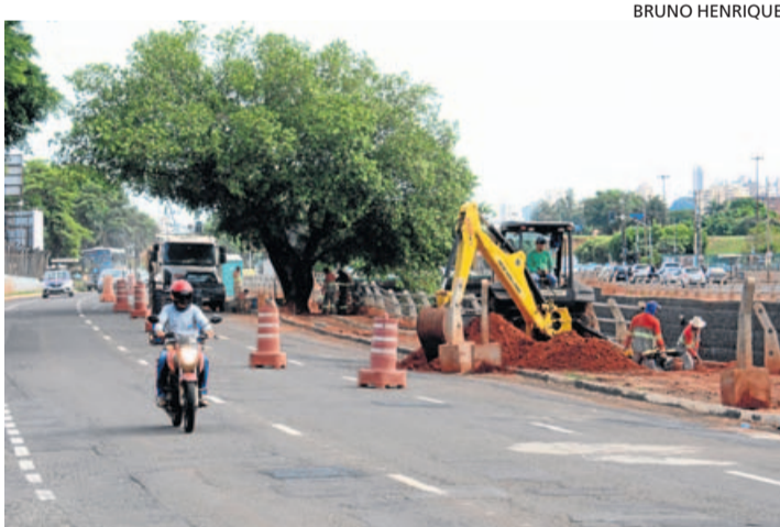
AVENIDA. Um dos três trechos em obra teve o trabalho retomado
